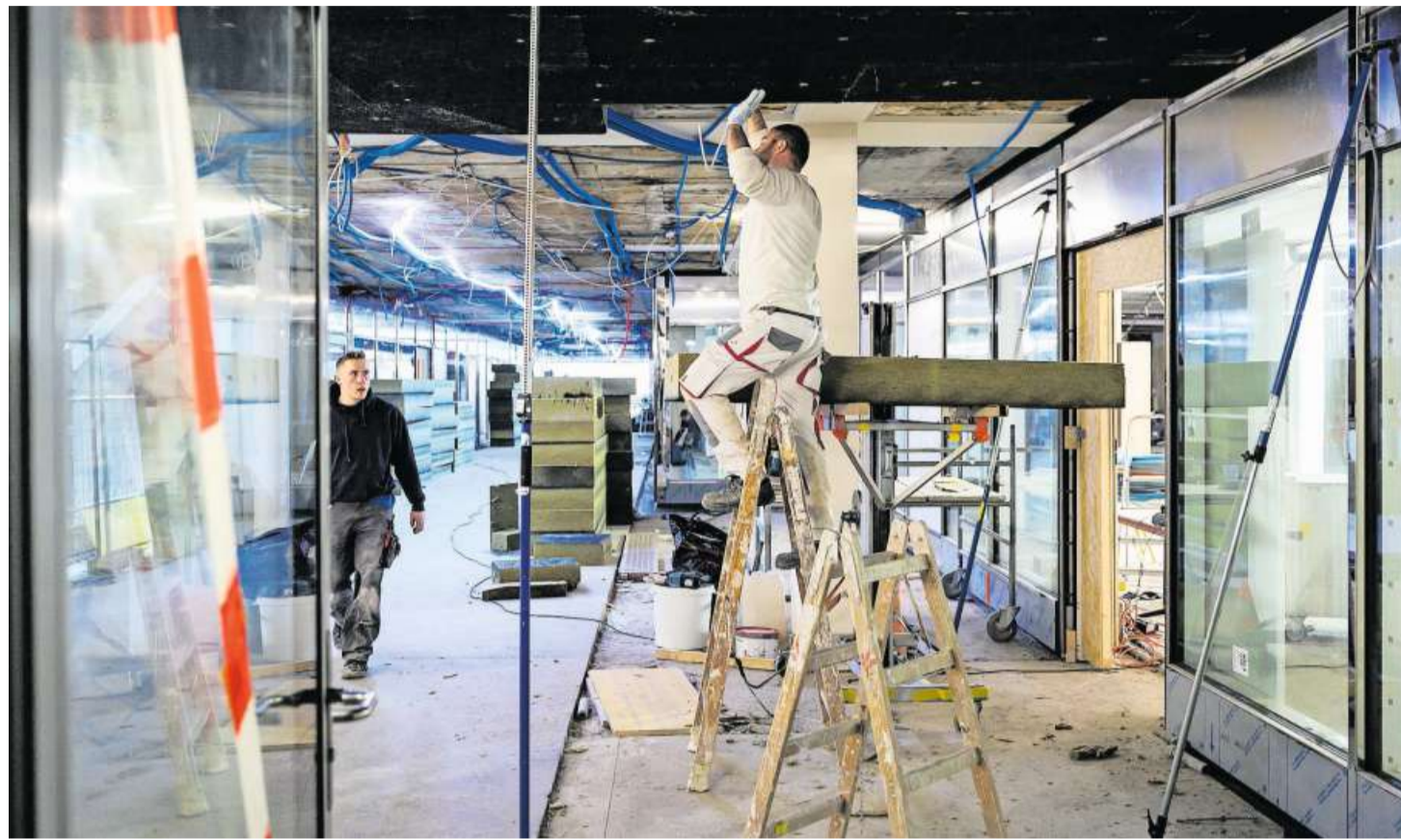
Die Arbeiten in der Unterführung sind noch im Gange.
