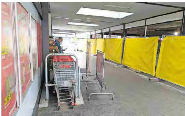
Links das jetzige Provisorium, rechts die künftige Filiale.
