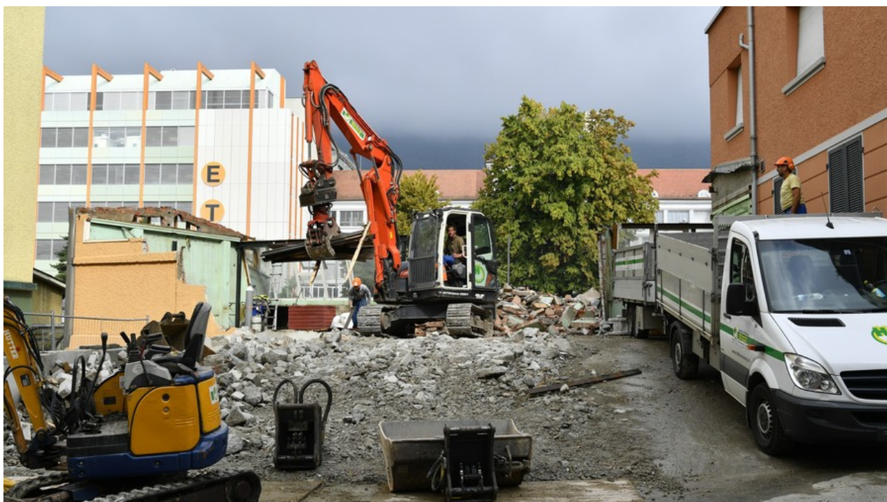
Neben dem Sorag-Hochhaus wird ein kleines Gewerbegebäude abgerissen.
