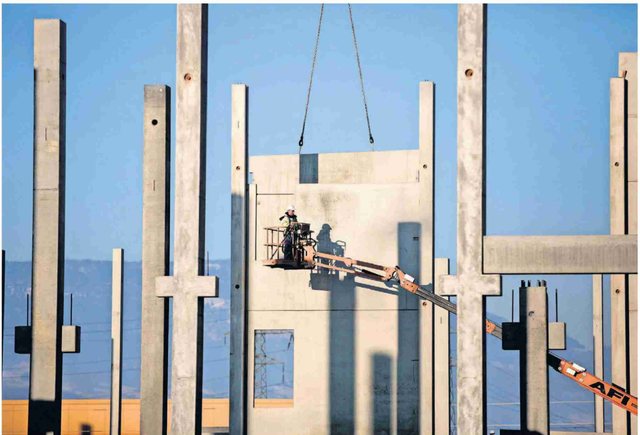
Die Betonplatten werden mithilfe eines Krans millimetergenau eingeführt und eingepasst.
