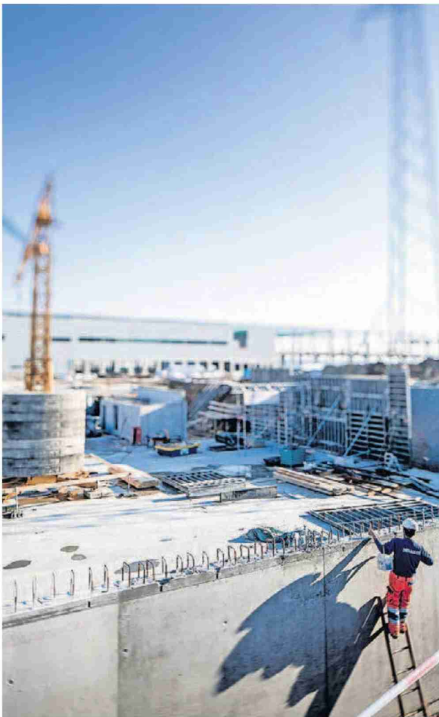
Die Einstellhalle wird zurzeit fertiggestellt.
