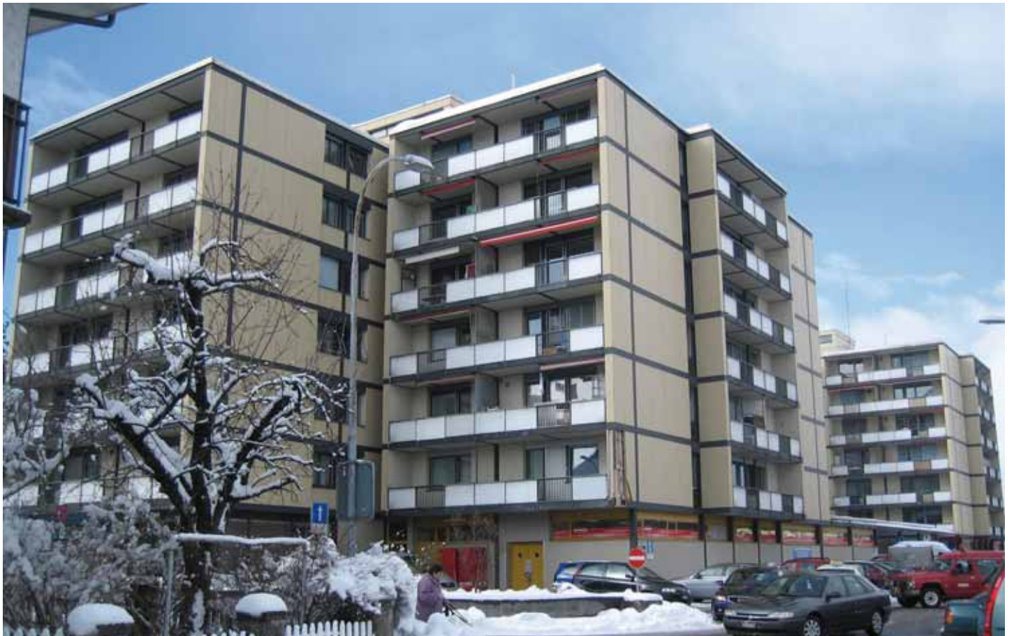
Zuchwilerstrasse 41 und 43, Solothurn
